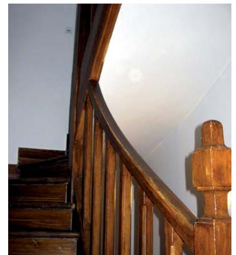
Escalier de presbytère
